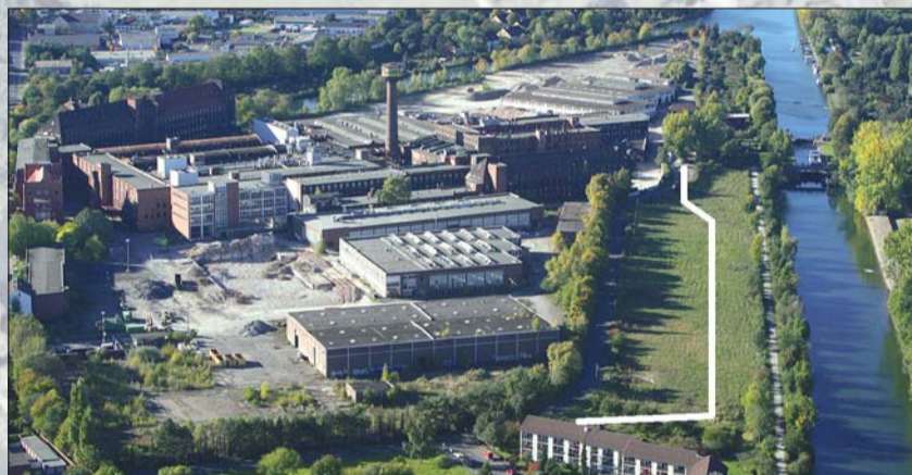
Die Fläche zwischen Wasserkante und der weißen Linie ist der Bereich des zukünftigen öffentlichen Uferparks. Foto: Karl Johaentges
